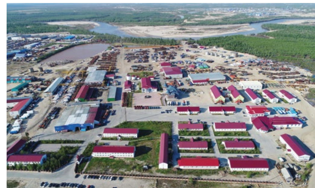
Производственная площадка компании расположена на площади 35,5 гектара
